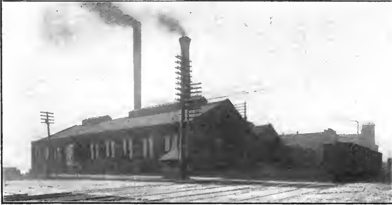
Das Maschinen-Haus der electricischen Licht-Anlage.
